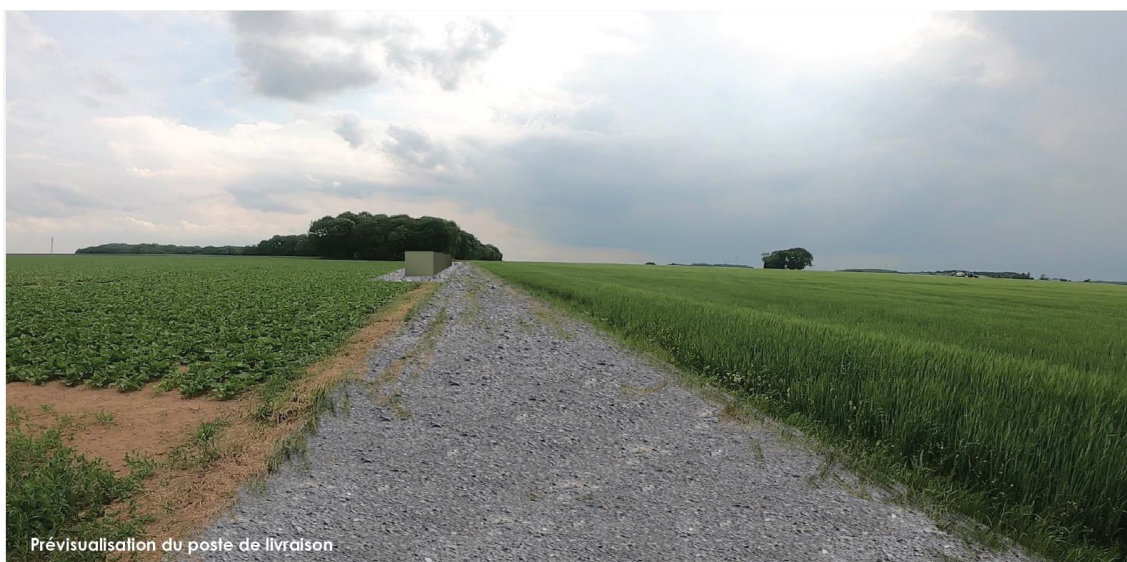
Figure 15 : Prévisualisation du poste de livraison de la Ferme éolienne du Champ Personnette
